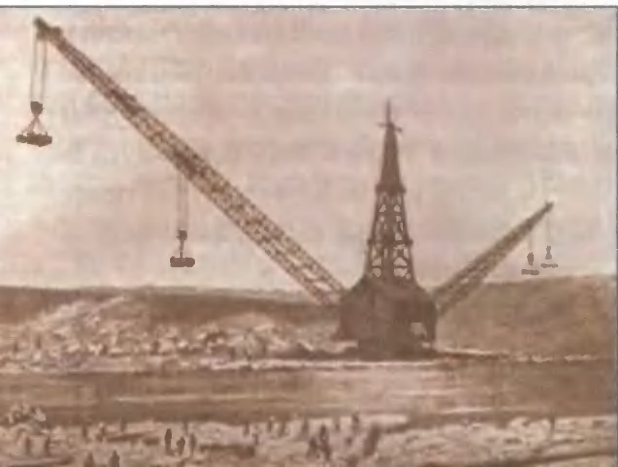
Экскаватор-кран на строительстве Чикагского канала, 1890-е годы.
